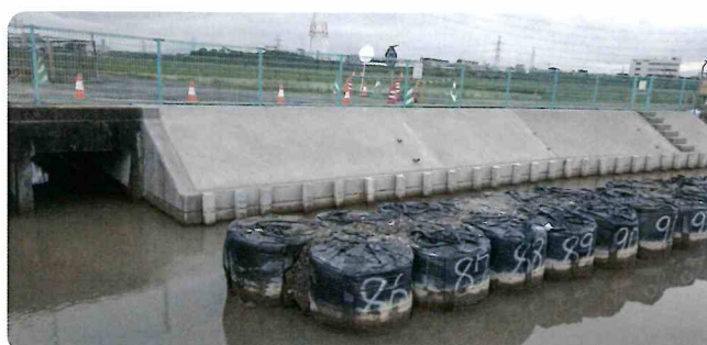
大池護岸の崩れ改修、 第 1 期改修工事が完成。 綺麗な水辺になります。
